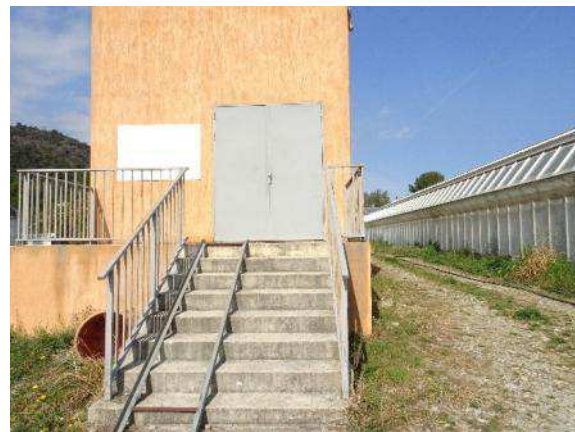
Figure 48 - Ancienne chaufferie à bois du CREAT © EGIS 2019
