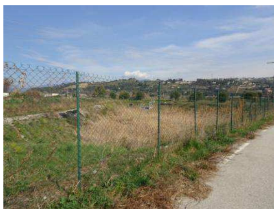
Figure 53 - Bassin de rétention © EGIS 2019
